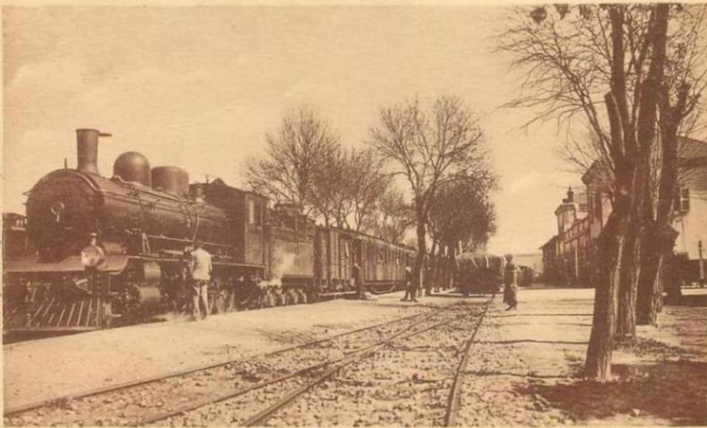
20. - BATNA. - Intérieur de la Gare
